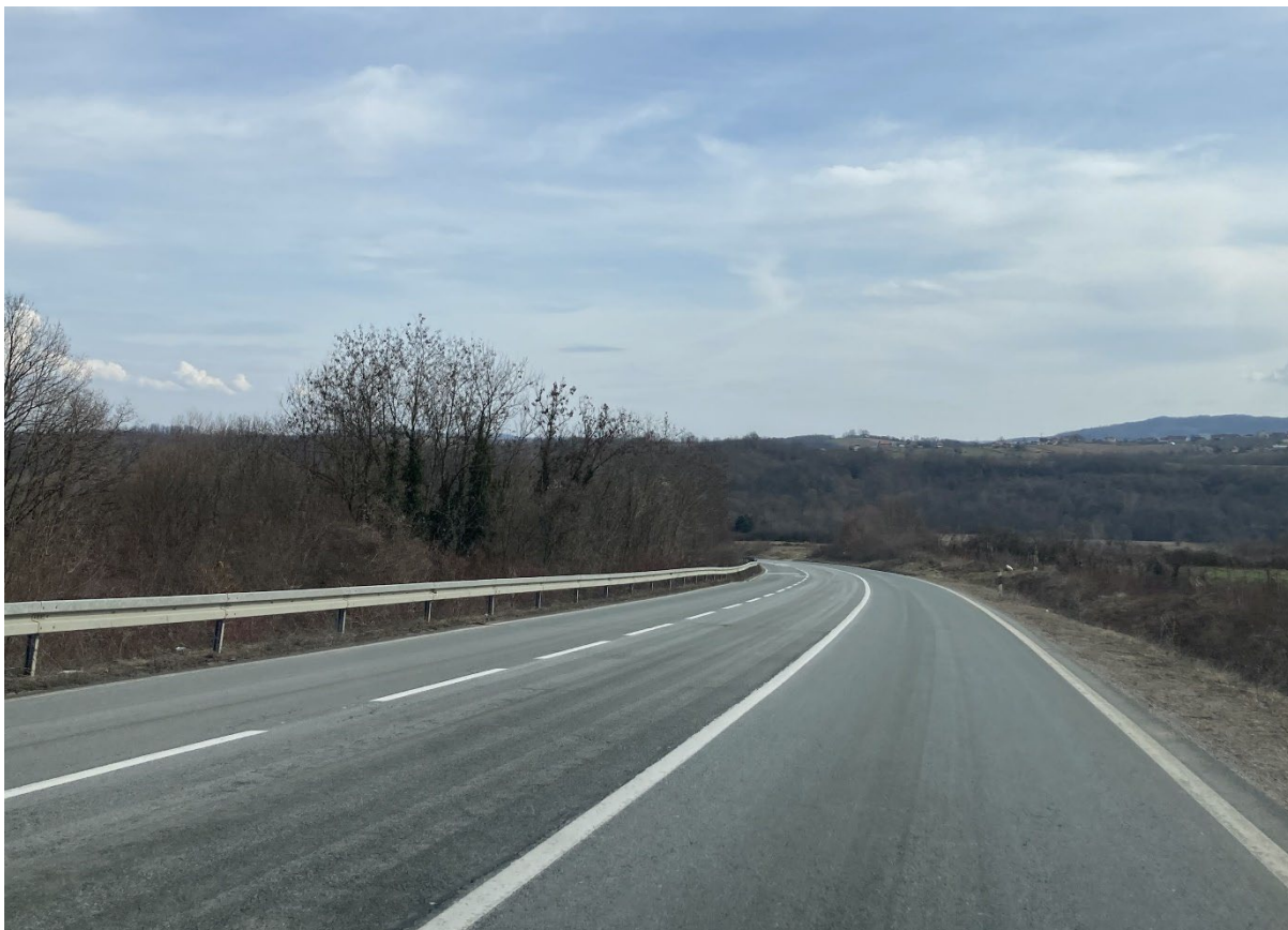
Фотографија 10 - Позиција 5 - Почетно стање
